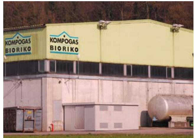
Kompogas Bioriko AG, System Kompogas, mit 20'000 t/a Verarbeitungskapazität
